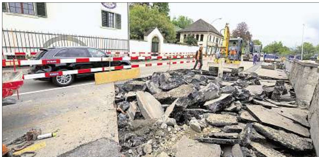
Beim Schipfgut an der Seestrasse in Herrliberg sind Bagger aufgefahren. (Reto Schneider)
